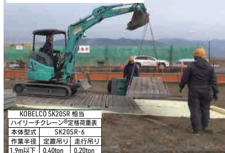
バックホウによる敷設状況
